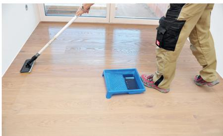
3) Nun kommt das jeweilige TRAPA Erstpflegeöl an die Reihe. Das Öl wird gut aufgeschüttelt, Weißöle zusätzlich aufgerührt, und in eine saubere Ölwanne gegossen. Mit dem Ölschwamm am Schwammpad Halter mit Gelenk wird das Öl nun hauchdünn aufgetragen. Dabei wird an den Rändern begonnen, und anschließend mit der Faser des Holzes gearbeitet.
