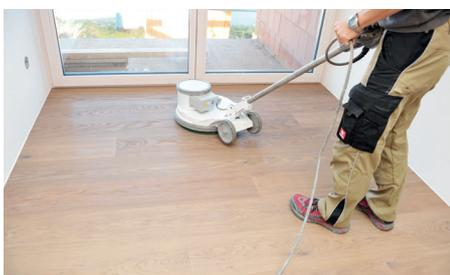
4) Gleich danach wird der Boden mit dem Maschinenölsaugpad Wolle zwischenpoliert. Die Ränder und Ecken werden mit dem Randhandpad Wolle extra bearbeitet, um auch hier, dieselbe Wirkung zu erzeugen. Mit dem Maschinenpolierpad Weiß wird der TRAPA Naturholzboden schließlich trockenpoliert.
