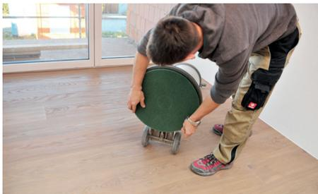
2) Im ersten Schritt kommt das Maschinentrockenpad Grün auf der Einscheibenmaschine zum Einsatz. In zügigen und gleichmäßigen Bewegungen wird der TRAPA Naturholzboden von allen kleinen und zum Teil nicht sichtbaren Verschmutzungen befreit, und danach nochmals abgesaugt.
