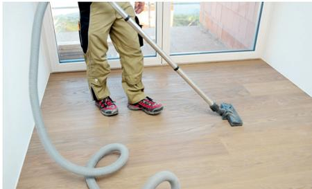
1) Zu Beginn der Erstpflege wird der Boden gründlich staubgesaugt. Etwaige Verschmutzungen, werden nun gründlich, aber schonend, also nicht durch scheuern, entfernt. Kleberreste beispielsweise können ganz leicht weggerubbelt werden, und für Gerbsäureflecken empfiehlt sich der TRAPA Gerbsäureflecken Spray. Der Spray wird auf den Fleck aufgetragen. Nach einer Einwirkzeit von rund einer Stunde ist der Fleck von ganz alleine verschwunden.
